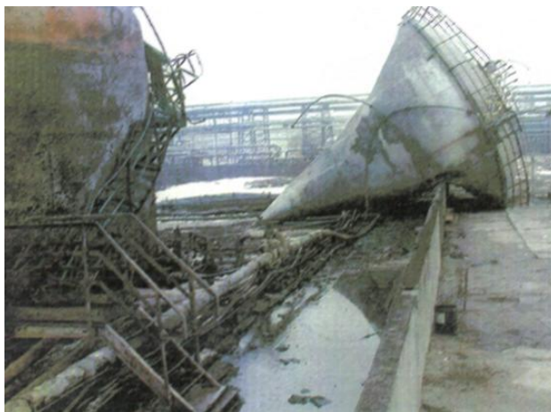
Fot. 6. Deformacje zbiornika ZM2; oderwanie od fundamentu wraz z widocznym przemieszczenie zbiornika poza betonowy murek
