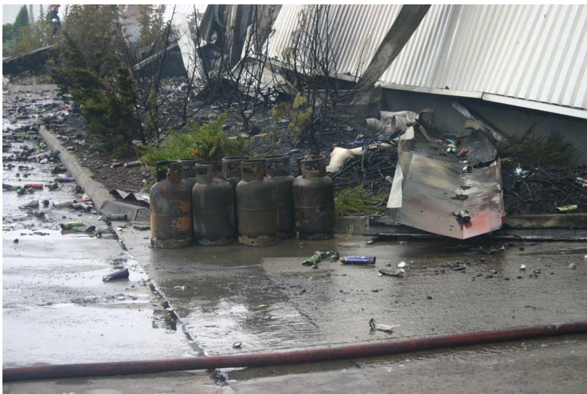
Widok zbiorników propan-butan przeznaczonych do zasilania wózków widłowych 7
