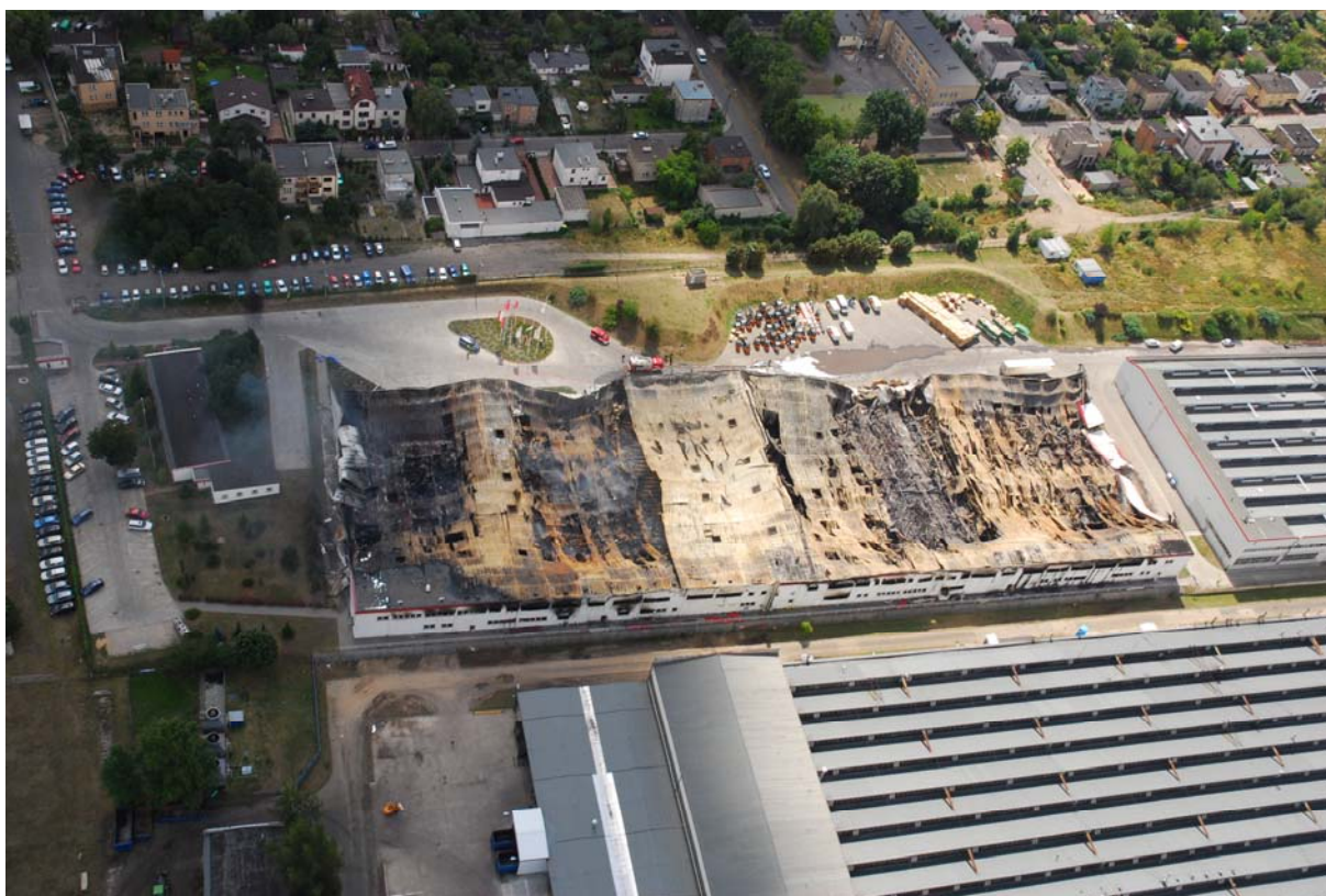
Widok spalonej hali magazynowej 8
