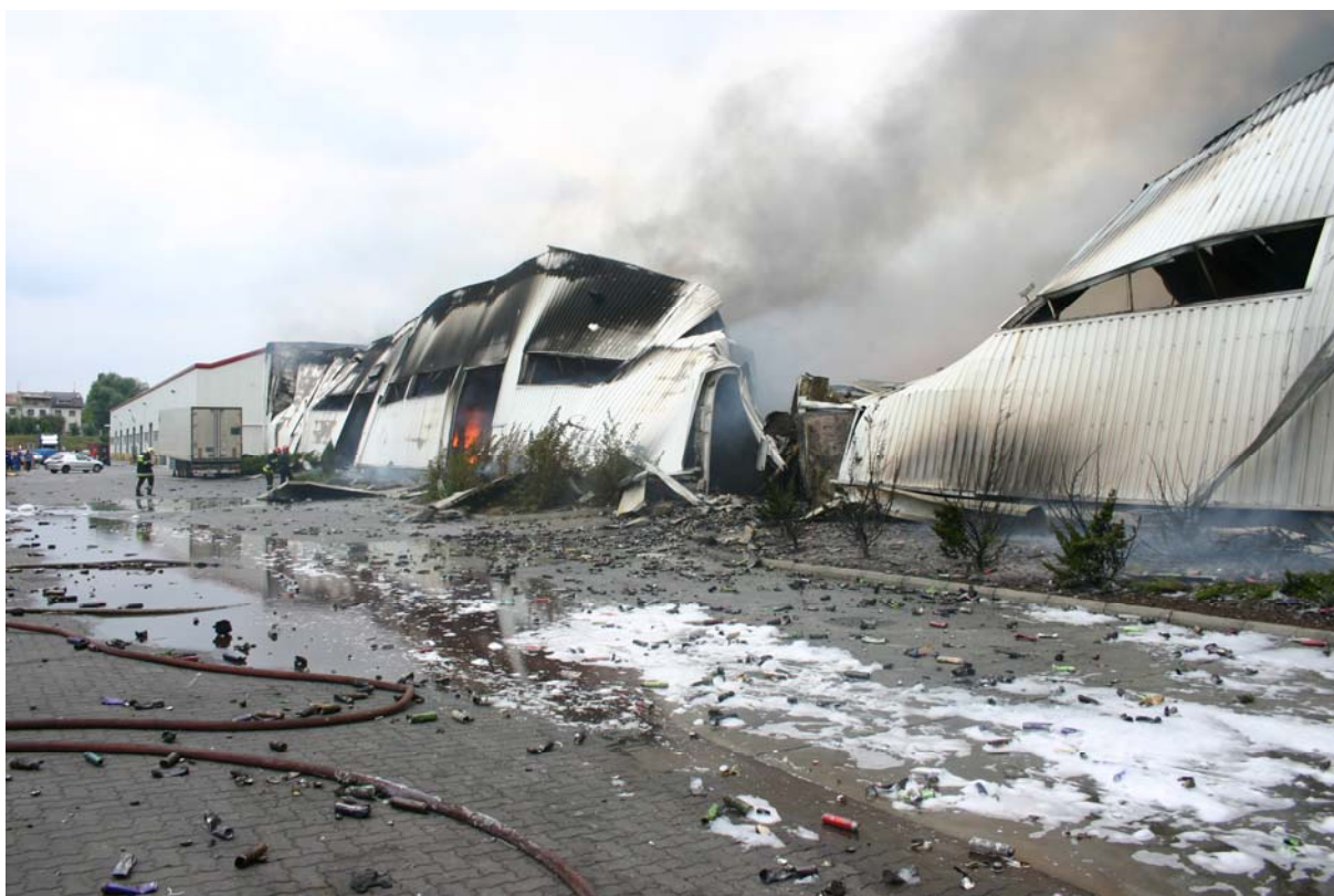
Widok zniszczonego budynku od strony wschodniej 2
